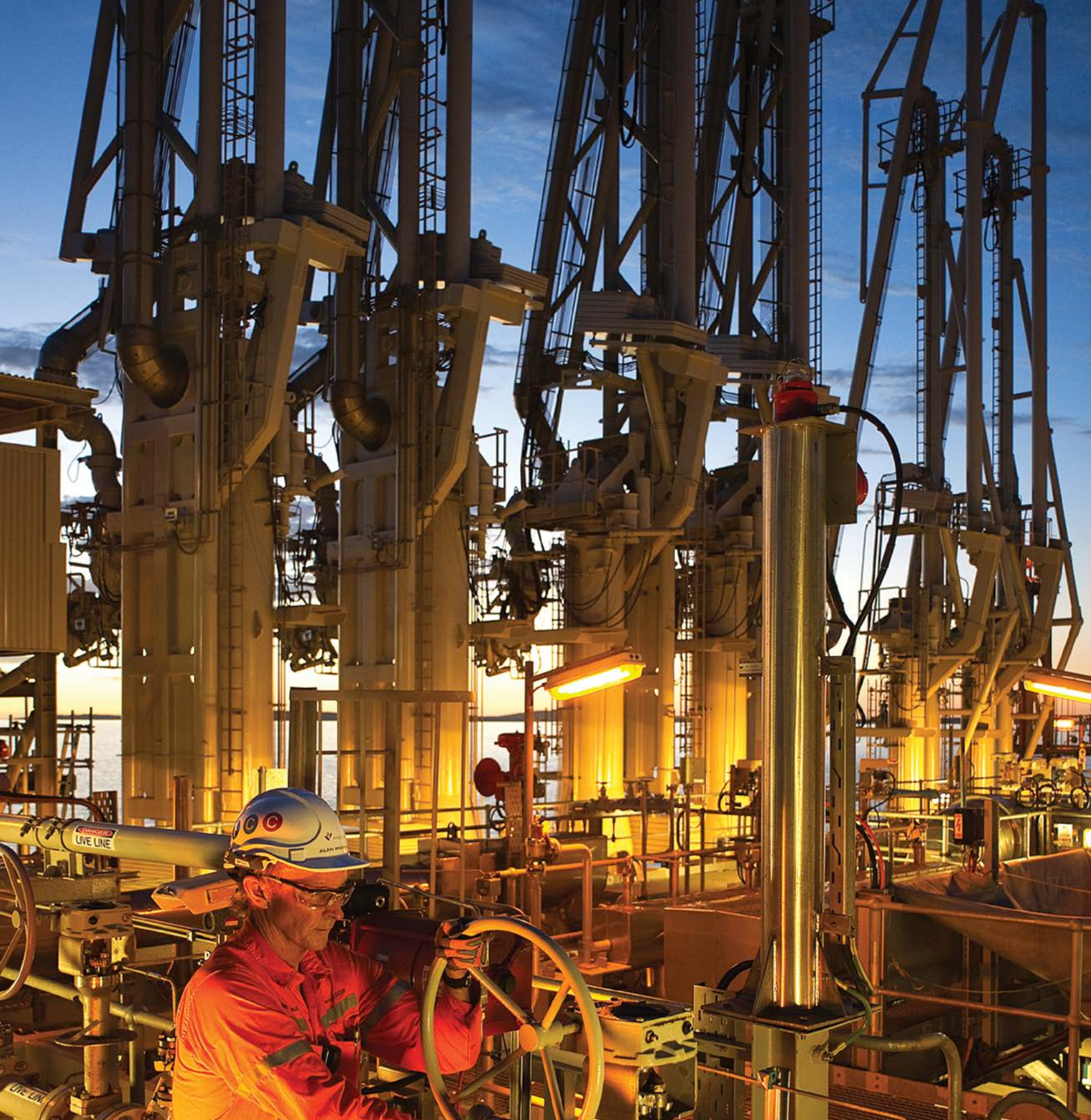
Pluto LNG Plant (Woodside)
