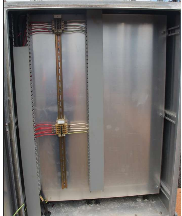
275kV Bus 2 CT marshalling kiosk
