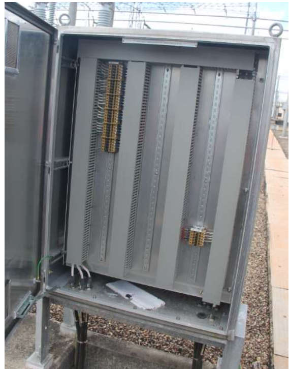
132kV 1 Bus CT marshalling kiosk
