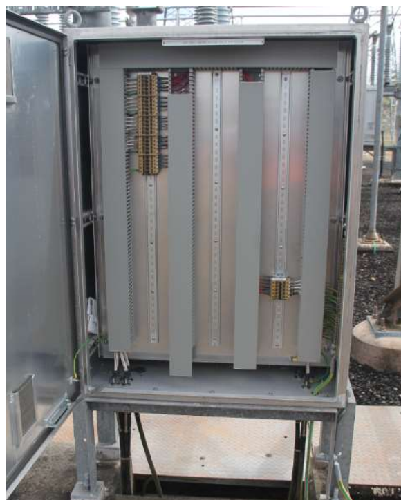
132kV 2 Bus CT marshalling kiosk
