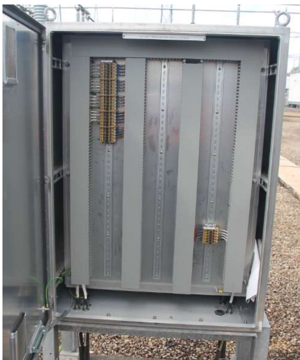
132kV 2 Bus CT marshalling kiosk
