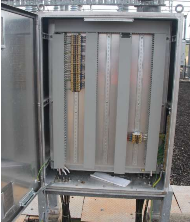
132kV 1 Bus CT marshalling kiosk
