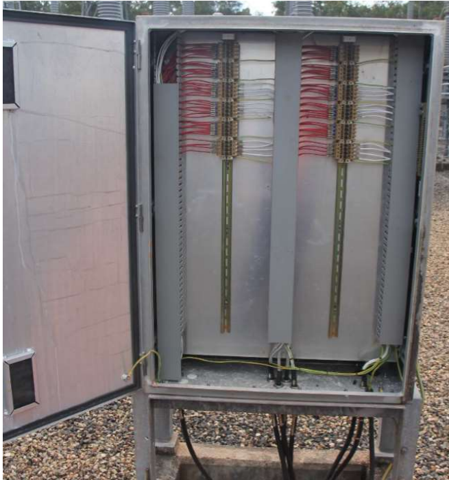
275kV Bus 2 CT marshalling kiosk
