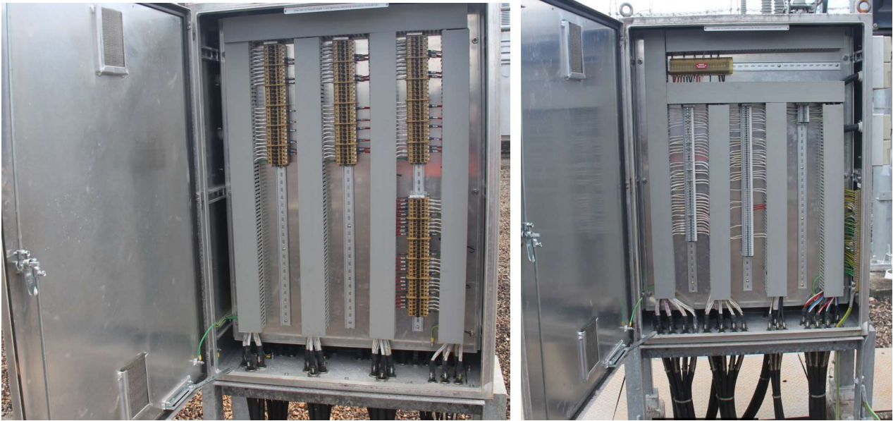
275kV 1T bay marshalling kiosk
