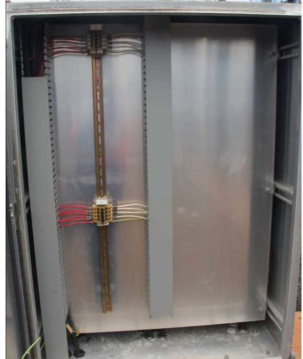
275kV Bus 2 CT marshalling kiosk
