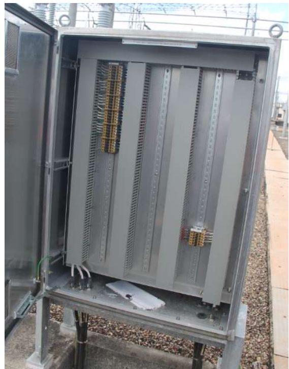
132kV 1 Bus CT marshalling kiosk
