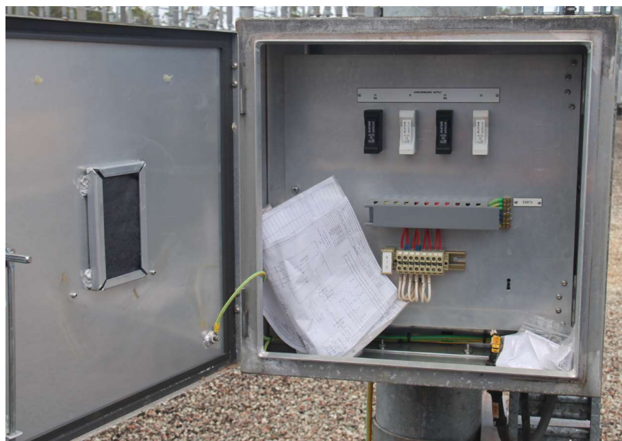
275kV Feeder 858 9VT marshalling kiosk
