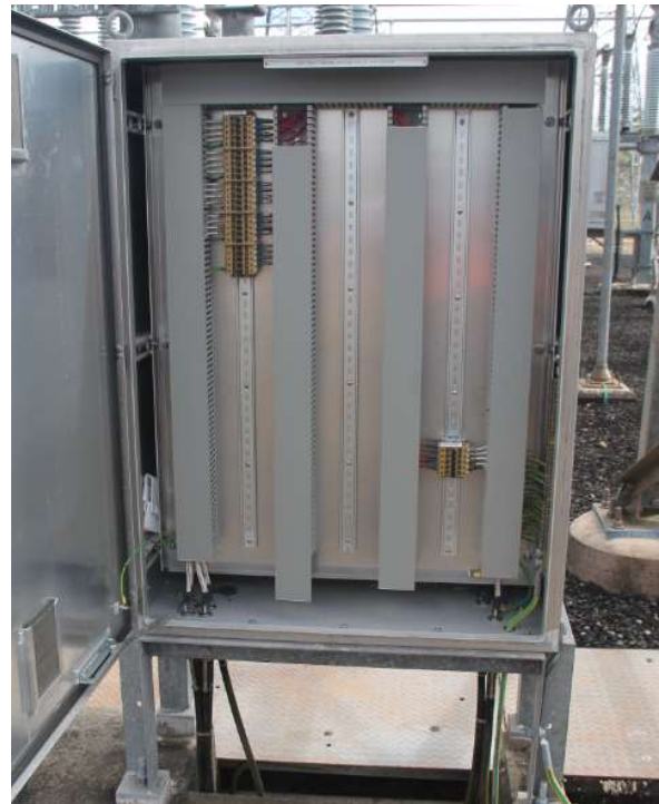
132kV 2 Bus CT marshalling kiosk
