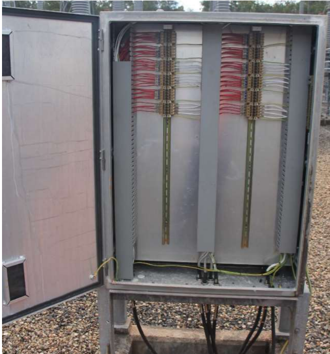
275kV Bus 2 CT marshalling kiosk
