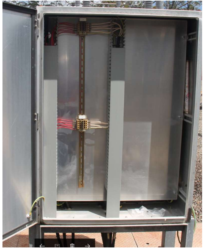
275kV bus 1 CT marshalling kiosk
