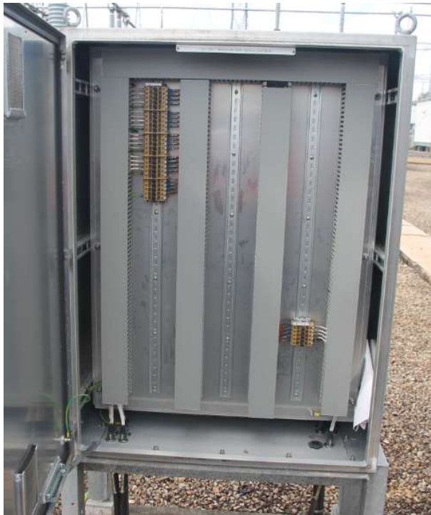
132kV 2 Bus CT marshalling kiosk
