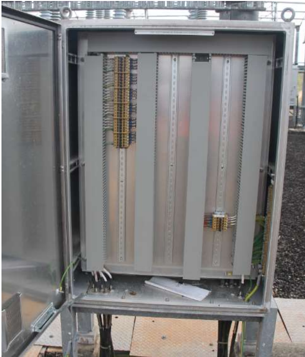
132kV 1 Bus CT marshalling kiosk
