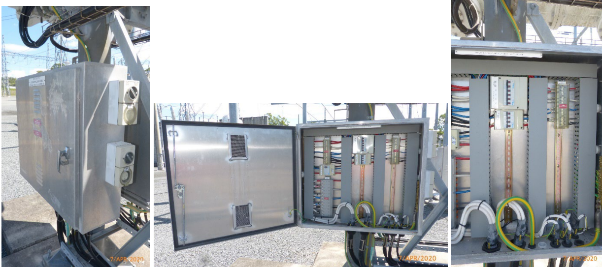
(d) 3 Bus 8 VT Marshalling Kiosk (+KD3-A10)
