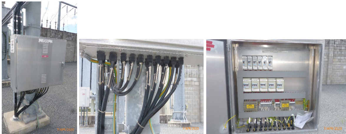
(d) 3 Bus 8 VT Marshalling Kiosk (+KD3-A10)
