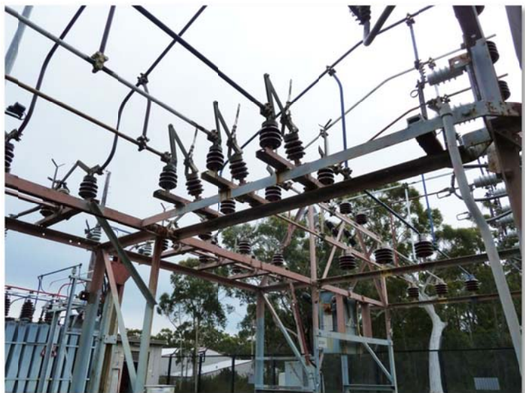
11kV bus-section isolator
