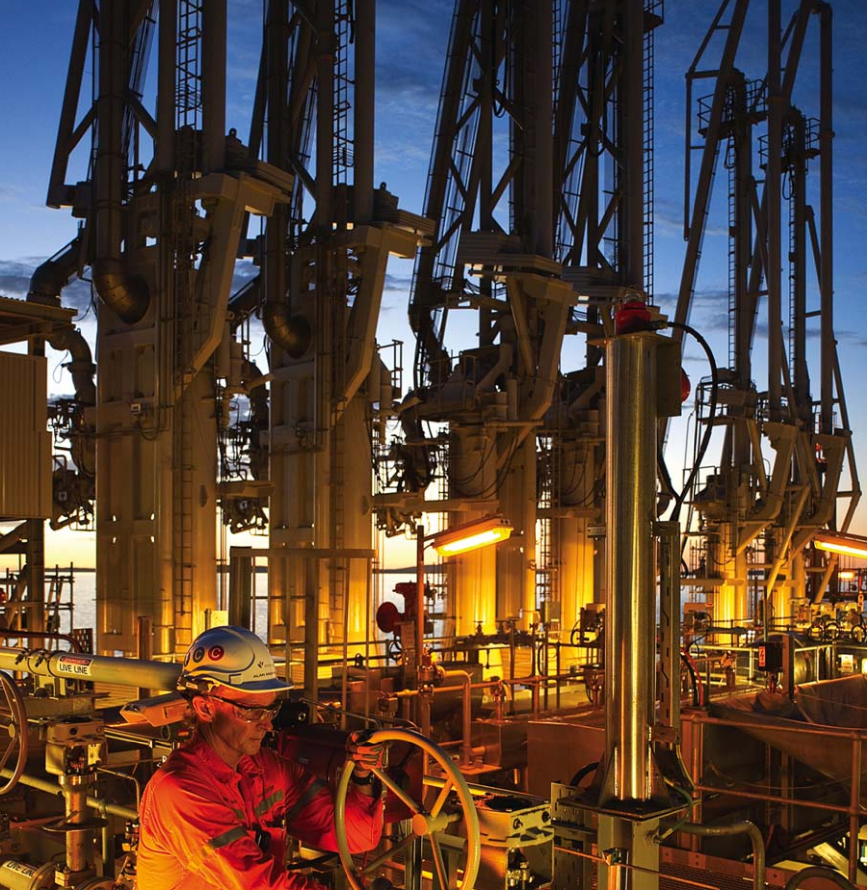
Pluto LNG Plant (Woodside)
